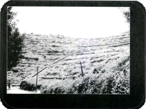
රූපය 9. පිටාර වේදිකා හා ජල පහිත ස්ථාන සහිත ප්‍රධාන කාණුවක ආකෘතියක් හා ප්‍රායෝගික යෙදුමක්
